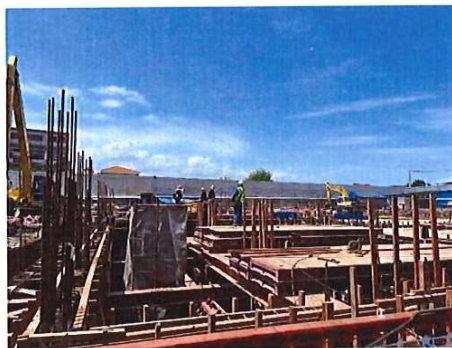
รูปที่ 5 แนว Sheet Pile และ Bracing (ค้ำยันเหล็ก)
