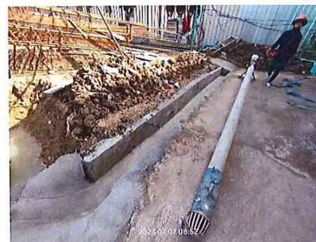
รูปที่ 7 วางระบายน้ำชั่วคราวในพื้นที่ก่อสร้าง
