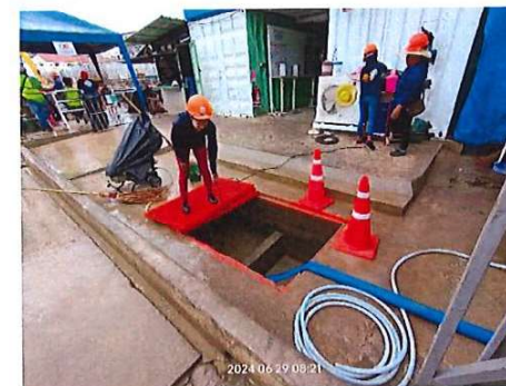
รูปที่ 7 วางระบายน้ำชั่วคราวในพื้นที่ก่อสร้าง
