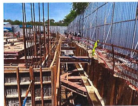
รูปที่ 5 แนว Sheet Pile และ Bracing (ค้ำยันเหล็ก)
