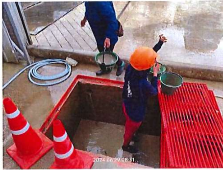
รูปที่ 8 ขุดลอกและทำความสะอาดบ่อพัก
