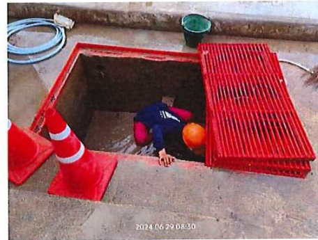
รูปที่ 8 ขุดลอกและทำความสะอาดบ่อพัก
